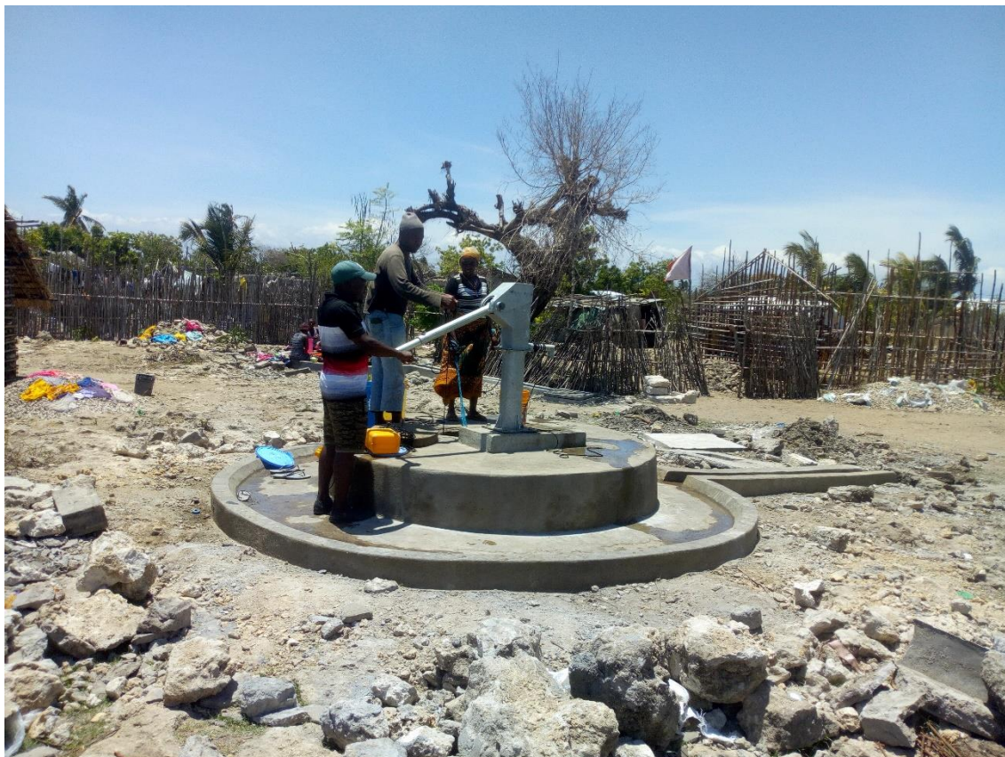
Fonte de água reconstruída após o ciclone Kenneth
