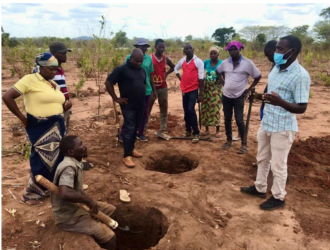
Processo de construção de latrina
